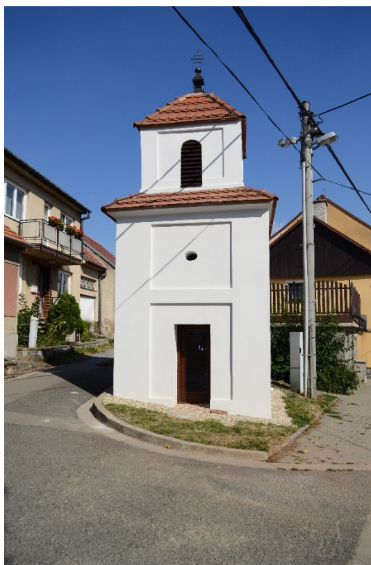
Zvonička po opravě v roce 2016
