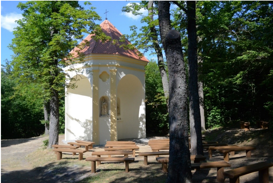
Kaple sv. Anny po opravě v roce 2013
