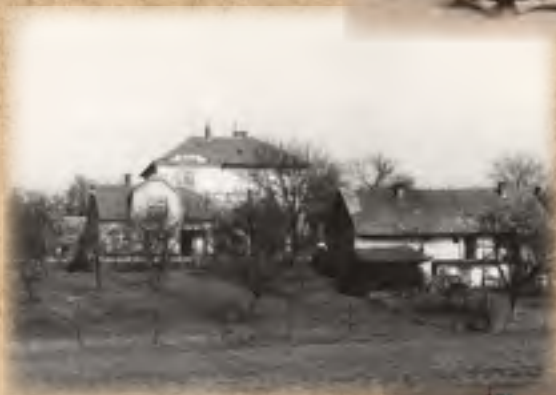
Pohled na budovu školy
