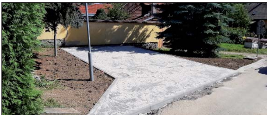
Sběrné místo po renovaci
