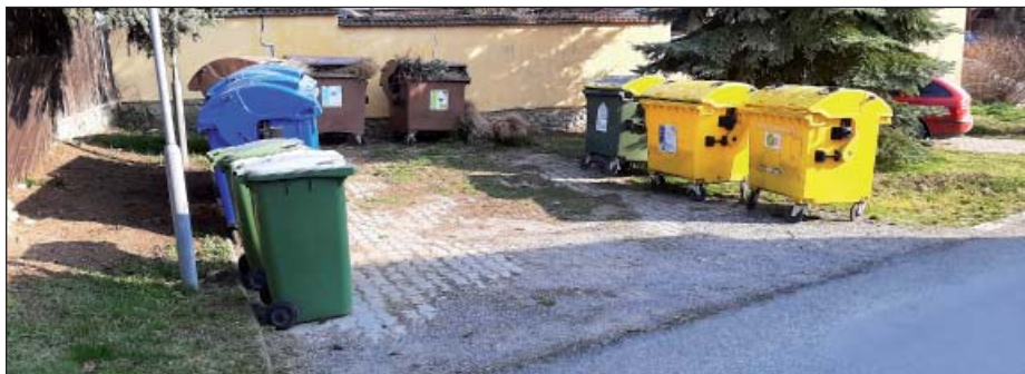
Sběrné místo před renovací
