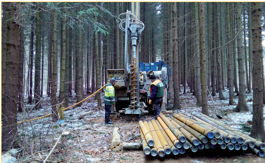
Vrtné práce na vrtu HO-3-17
